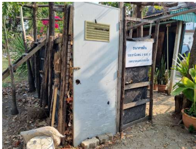
ธนาคารดินก่อนปรับปรุงซ่อมแซม
